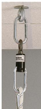
La base de l'anneau de fixation doit être affleurant au plafond. Il ne doit pas y avoir d'espace entre la base de l'anneau et la surface du plafond.
